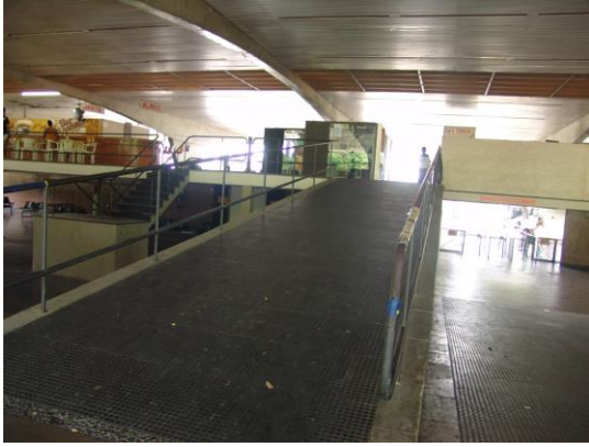
Figura 05 – Rampa de acesso ao pavimento superior. Possui inclinação superior a 11%. Fonte: Acervo próprio
