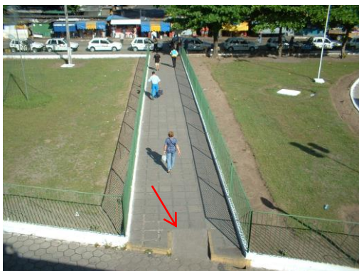
Figura 02 – Acesso de pedestres, com uma rampa para pessoas com deficiência, dando acesso a uma via interna de circulação de veículos. Fonte: Acervo próprio
