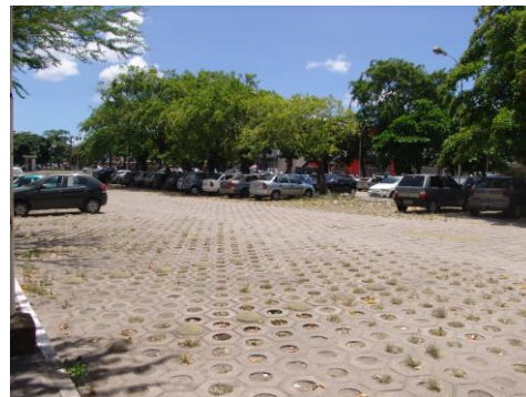
Figura 03 – Piso sextavado utilizado no estacionamento. Fonte: Acervo próprio
